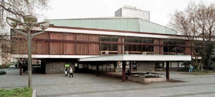
In der „alten“ Mercatorhalle, hier fotografiert im April 2002, waren über Jahrzehnte internationale Superstars zu Gast. MANGEN/FFS
